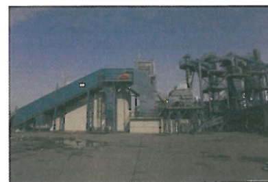
Az ALCUFER Kft. fehérvárcsurgói shredder-berendezése
